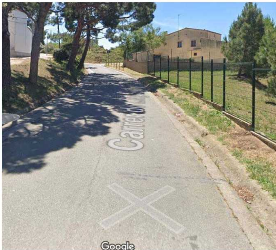
Imatges de l'estat actual de la vorera
